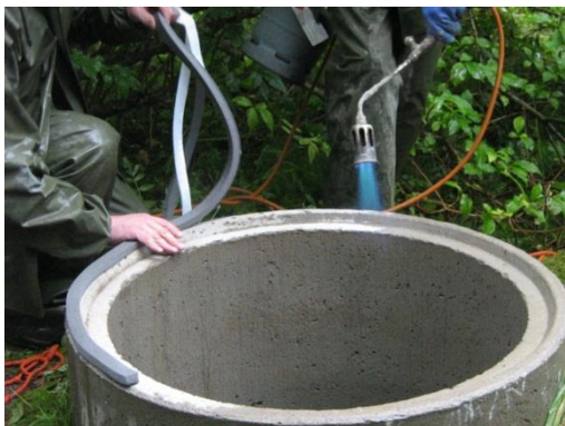
Placering av gummitätning. Foto: Sanna Vienonen
