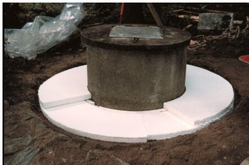
Schaktbrunns värmeisolering vågrät. Foto: Erkki Santala
