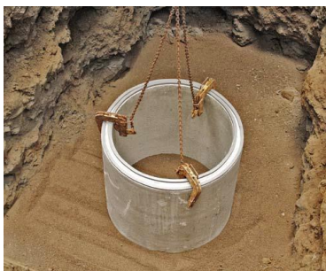
Placering av den nedersta brunnringen. Foto: Tuomo Hatva
